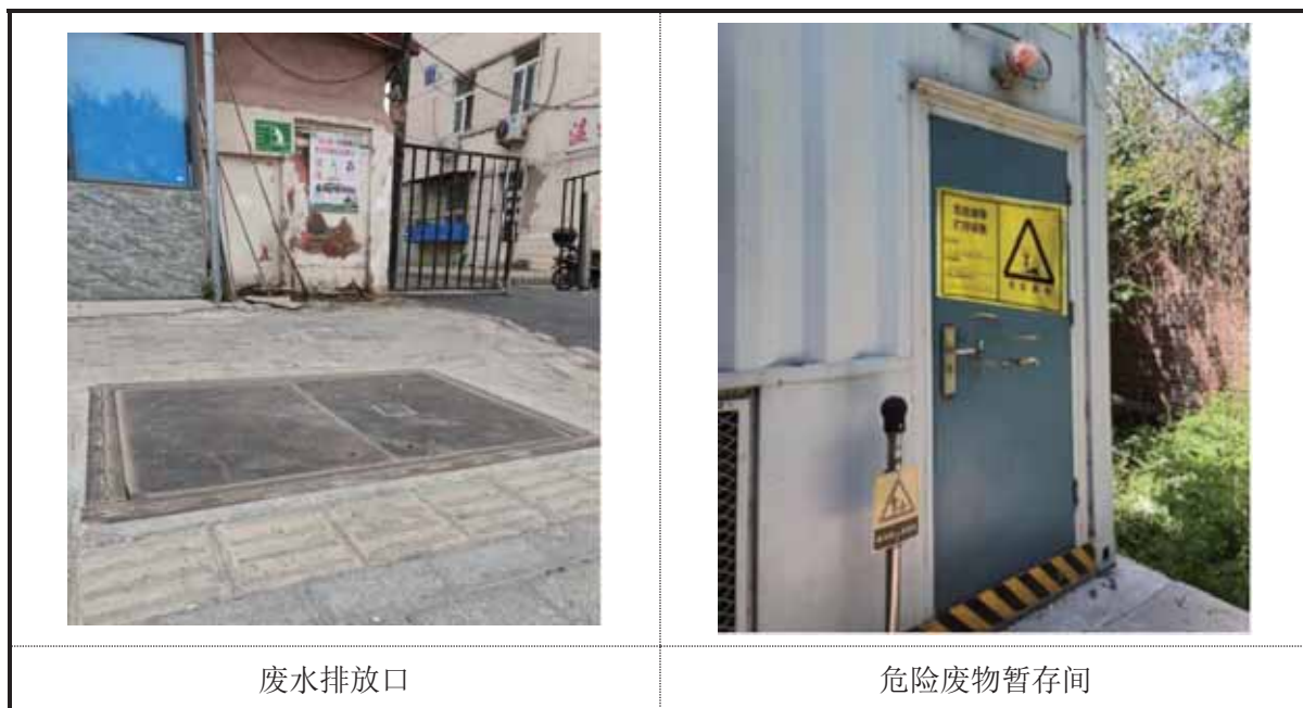
图 3-3 排污口规范化建设现状
