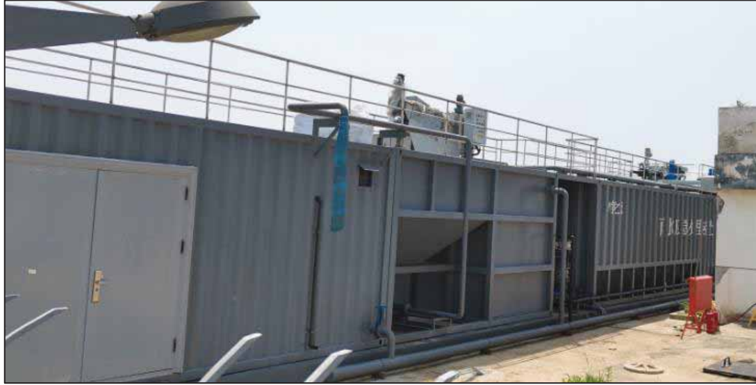
图 4-12 初期雨水净化装置实际安装情况图
