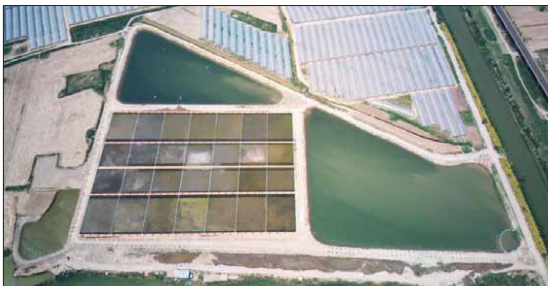
葛沽镇九道沟东部人工湿地（2023 年 5 月拍摄，无人机 500m 高空）
