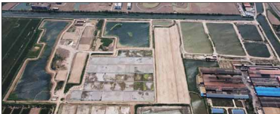
葛沽镇九道沟西部人工湿地（2023 年 5 月拍摄，无人机 500m 高空）
