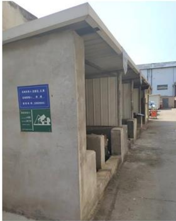
一般固废暂存间
