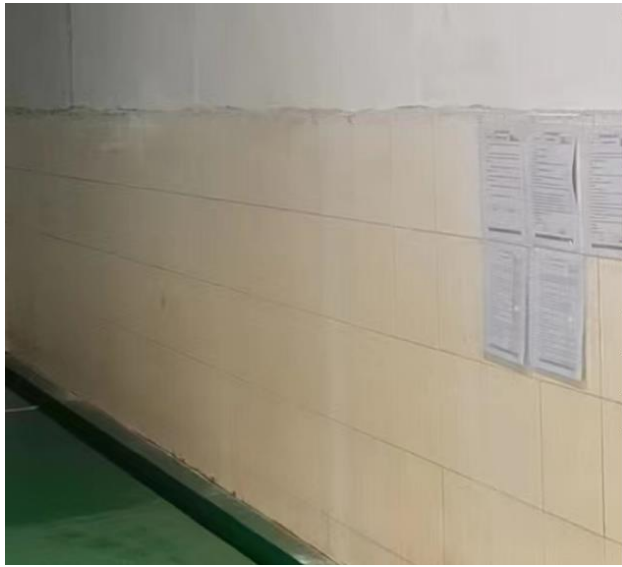
危废暂存间内部
