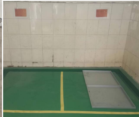
危废暂存间内部
