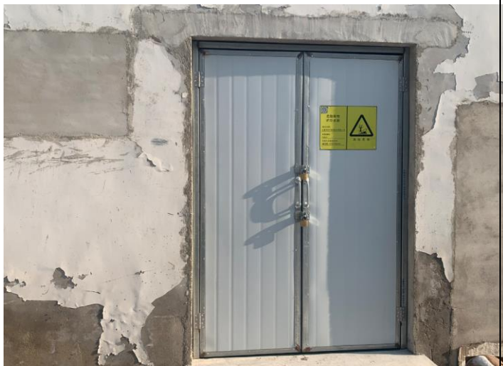
危废暂存间外部
