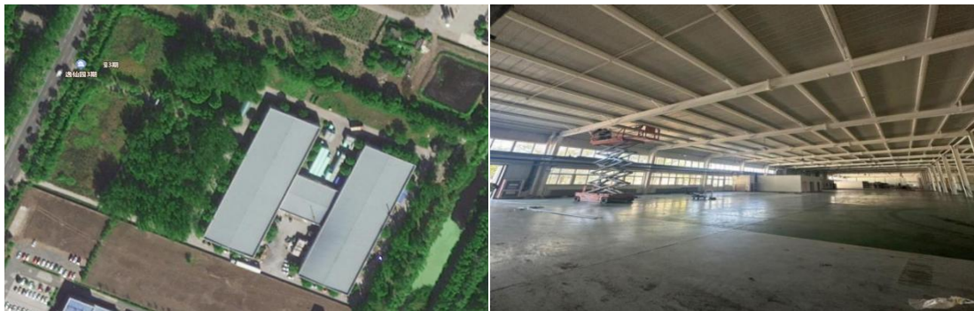
图 4 厂房现状照片
