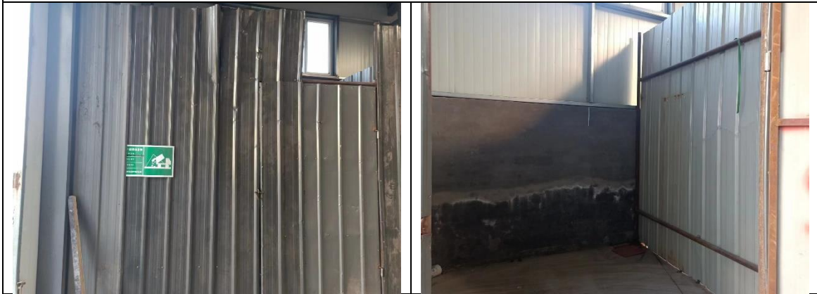
图 3-3.2 一般固废暂存区
